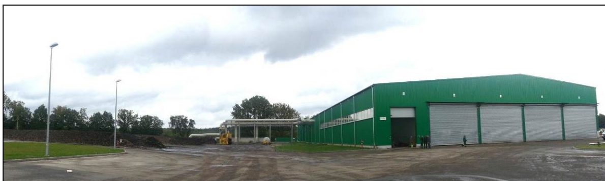
Instalacja w Słajsinie
