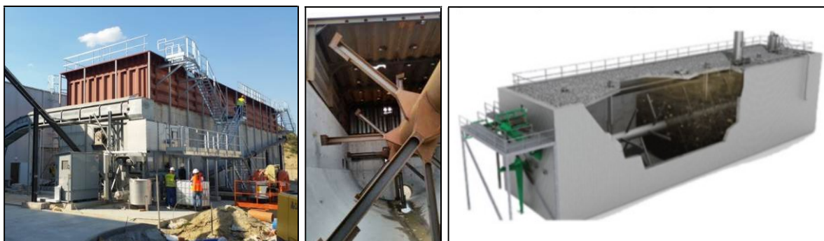
Budowa instalacji w technologii Kompogas, fot. proGEO, s prawej schemat [ http://www.hz-inova.com/ ]
