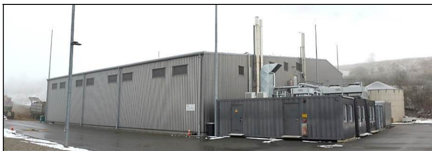
Technologia BioFerm (Viessmann Group) – Allendorf (Niemcy), fot. proGEO
