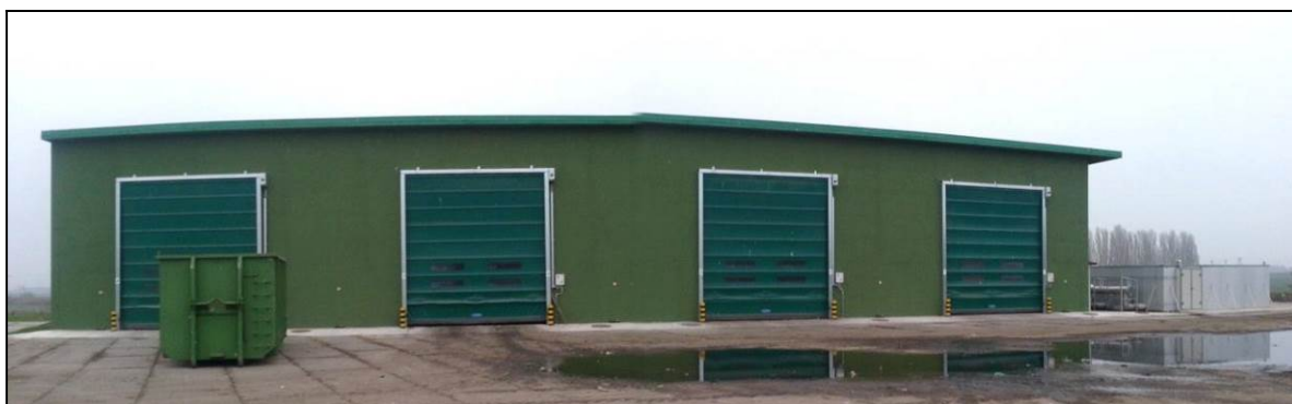
Instalacja Entsorga w Inowrocławiu
