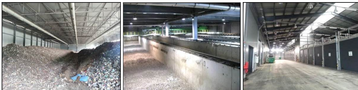
Technologia pryzmowa w hali Nova-Komp, Ślajzino (1), dynamiczna BIOFIX, Radom (2), M-U-T, Myślenice (2)
