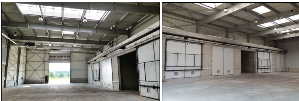
Instalacja w Stalowe Woli
