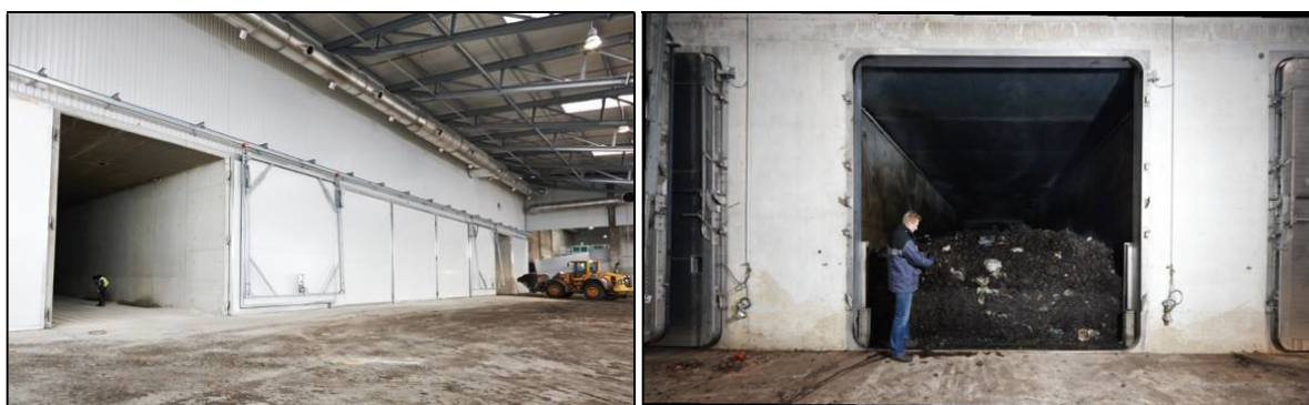
Technologia W.T.T. Wiefels i Venneberg (Niemcy), fot. www.wtt.nl
