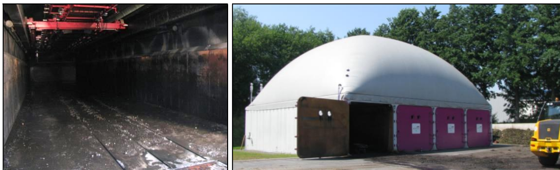
Technologia Kompoferm – reaktor, z prawej instalacja Smartferm w Bad Oeynhausen (Niemcy), fot. proGEO
