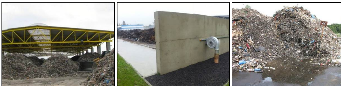
Technologie stabilizacji na placu (11): z napowietrzaniem w wiacie, z napowietrzaniem na placu, przyzłomowa
