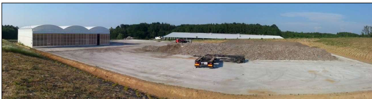
Instalacja w Domaszkowicach k. Nysy
