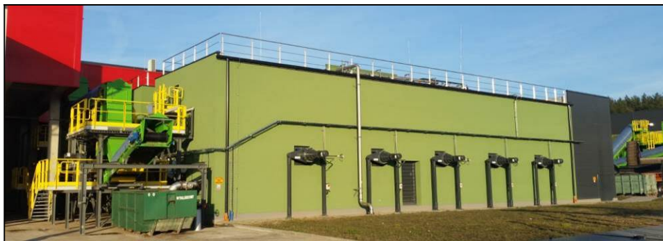
Technologia Strabag – Promnik k. Kielc, fot. proGEO
