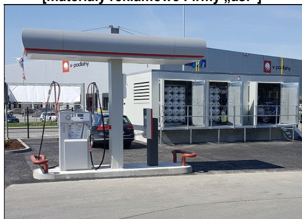
Rysunek 3.6 Stacja dystrybucji CNG w zabudowie kontenerowej - wyciszona. [materiały reklamowe Firmy „asf”]
