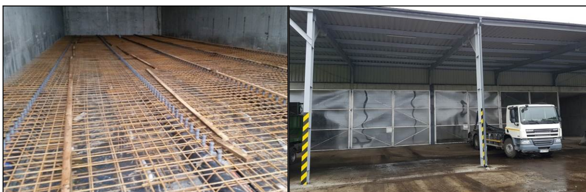
System dysz napowietrzających (w trakcie budowy), drzwi przesuwne (Radzyń Podlaski)
